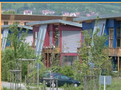
Nahwärme-Solarhäuser in Lörrach Stetten
