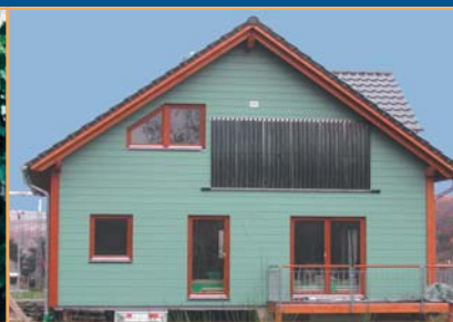
Einfamilienhaus mit Fassadenbefestigung
